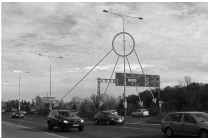
Slika 17: Montirana visoko nad cestiščem omogoča spremljanje prometa na 4 voznih pasih hkrati
