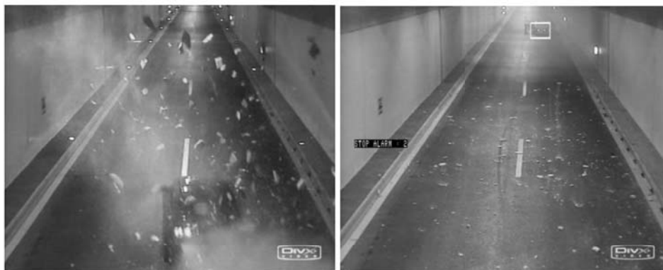
Slika 6: Odpadanje ometa v predoru Šentvid
